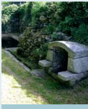
Cet ensemble hydraulique se situe dans le bourg et se compose de trois éléments : une fontaine qui abrite la source d'alimentation, un canal et un lavoir. La fontaine, maçonnée en pierre de taille (granit), est intégrée dans la pente du terrain. Elle forme une niche protectrice au-dessus du bassin de puisage. Des reposoirs sont intégrés dans la maçonnerie, de part et d'autre de la margelle. Très fonctionnel, l'agencement dénote également une volonté décorative : la
